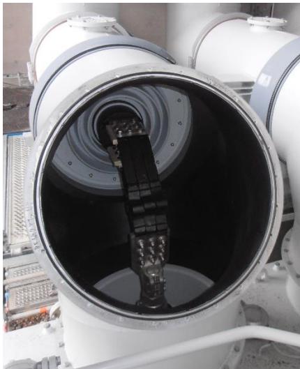
Rys. 1. Złącze elastyczne elementu szyno-toru.
